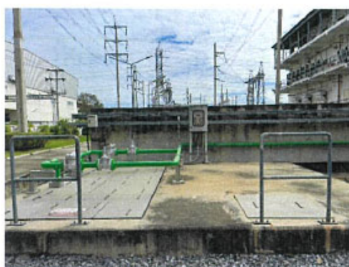
ภาพที่ 2.2-4 บ่อแยกน้ำ-น้ำมัน
