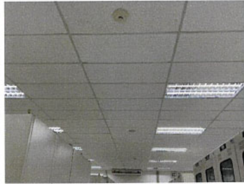
ภาพที่ 2.2-28 สัญญาณเตือนภัยแบบอัตโนมัติ
