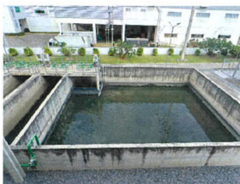
ภาพที่ 2.2-6 บ่อพักน้ำหลังการบำบัด
